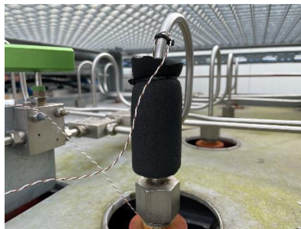
Abbildung 10: Nachgerüstete Messstellen am Hochdruckspeicher (Segmente 6-7)
