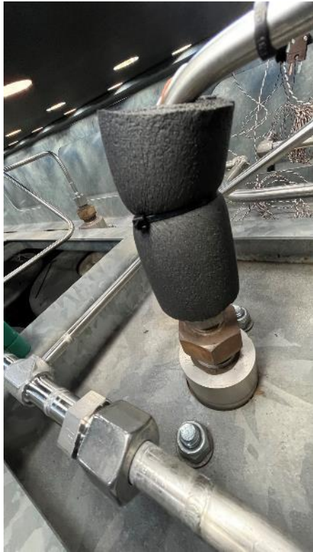
Abbildung 8: Nachgerüstete Messstellen 10-13 am Mitteldruckspeicher (Segmente 1-3)
