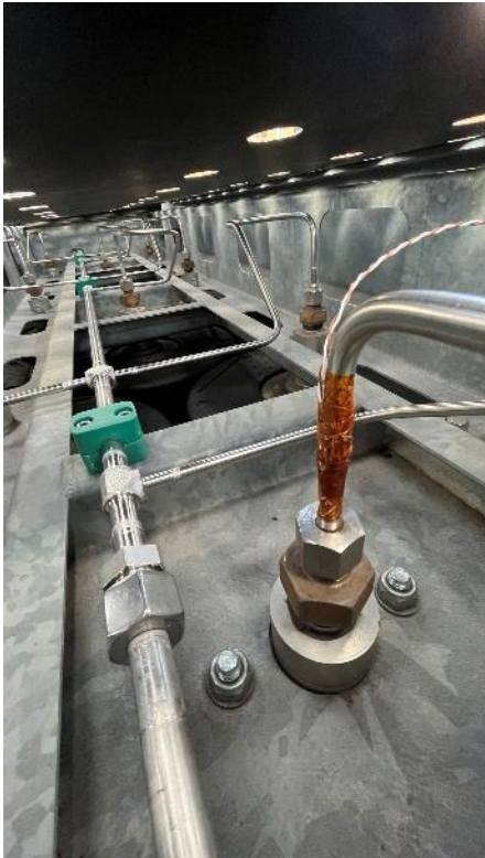
Abbildung 8: Nachgerüstete Messstellen 10-13 am Mitteldruckspeicher (Segmente 1-3)
