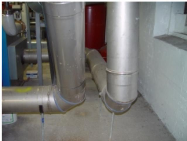
Abbildung 23 Abgasleitung nach Heizkessel
