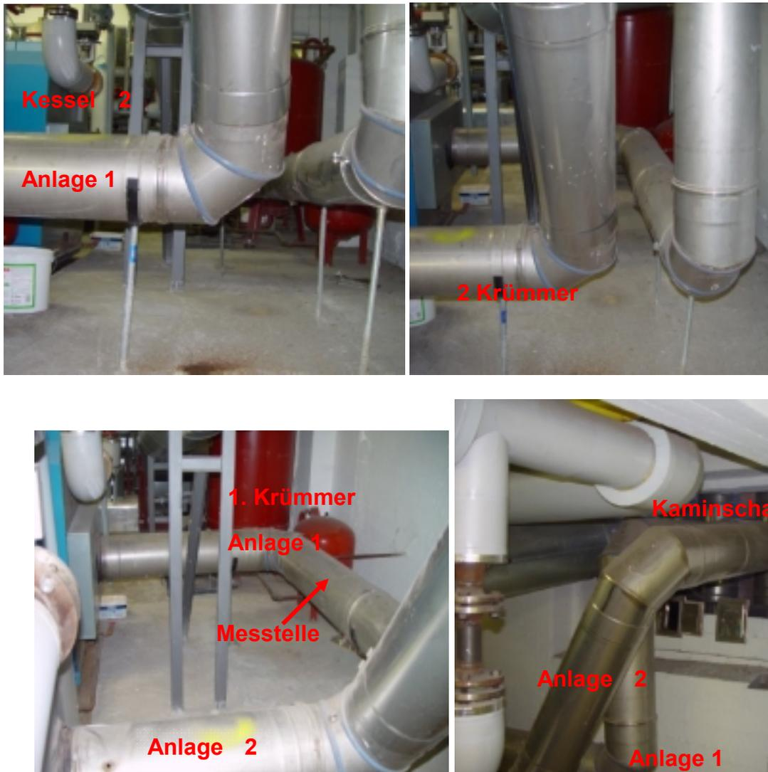
Abbildung 4 Abgasrohre der Heizungsanlage, Abgasrohre der Kessel 1 und 2
